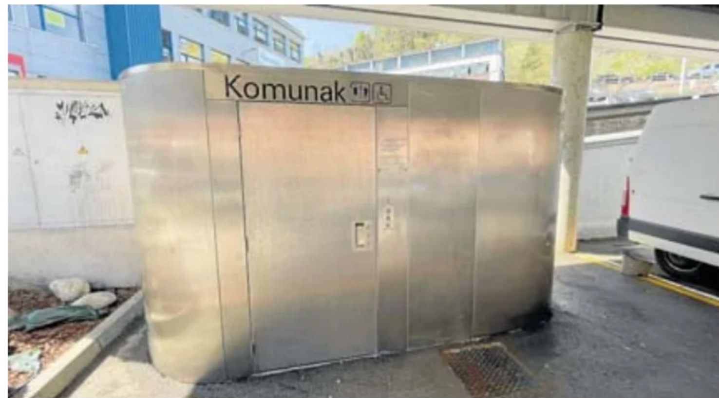
Vista del baño público situado en el 'probaleku' de Sigma, que ya ha sido limpiado a fondo. dv
