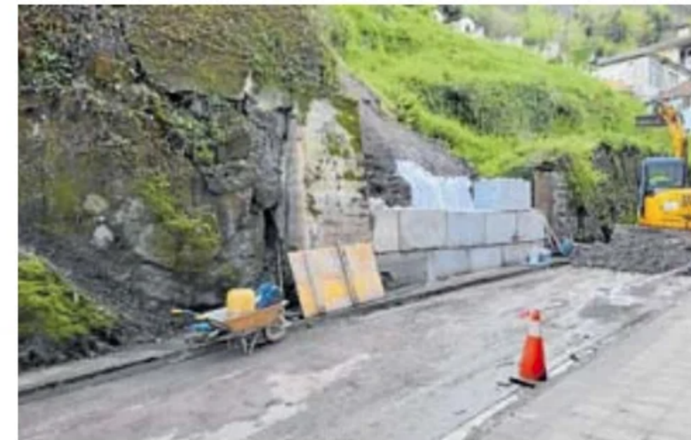
Los trabajos para reparar el desprendimiento en Atxuri kalea. UDALA
