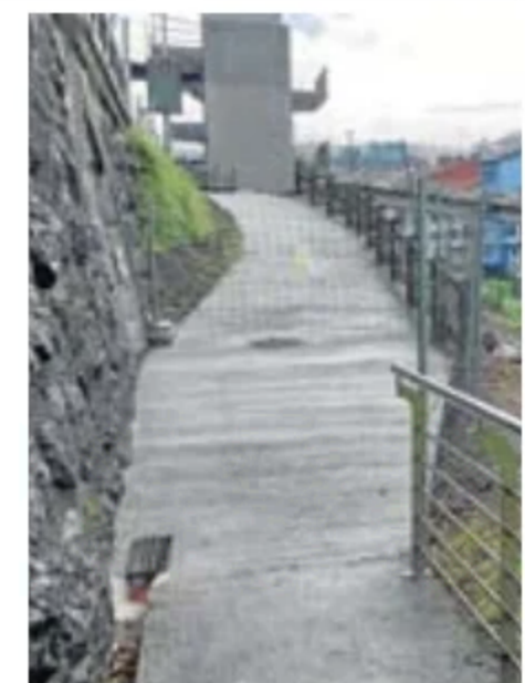
La rampa, renovada. DV
